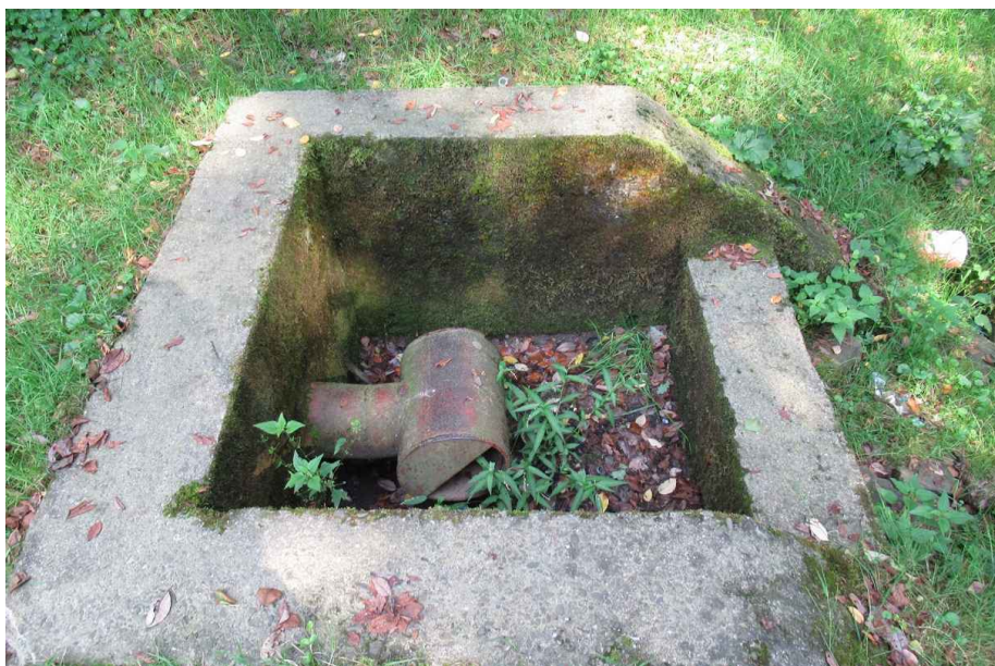
Obrázek č.24: Odlehčovací komora v úseku Dubina C. V pravé horní části obrázku je patrné vyústění trativodu.
