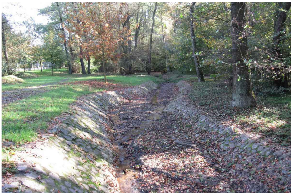
Obrázek č.23: Umělá úprava koryta toku v úseku Dubina C.
