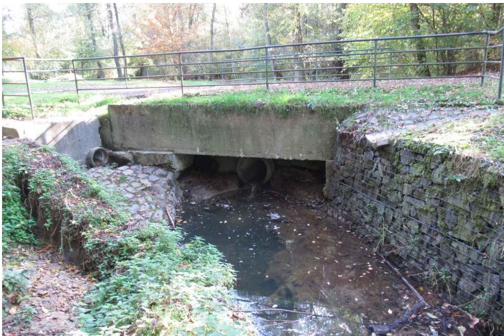
Obrázek č.21: Propustek uprostřed úseku Dubina C. Na obrázku je patrné i zhroucení gabionové stěny (vlevo).
