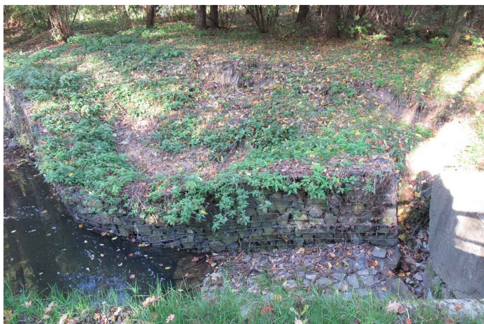
Obrázek č.22: Zhroucená gabionová stěna v úseku Dubina C.
